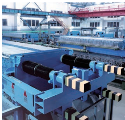
塩素回収電解槽 Chlorine recycling electrolyzer
